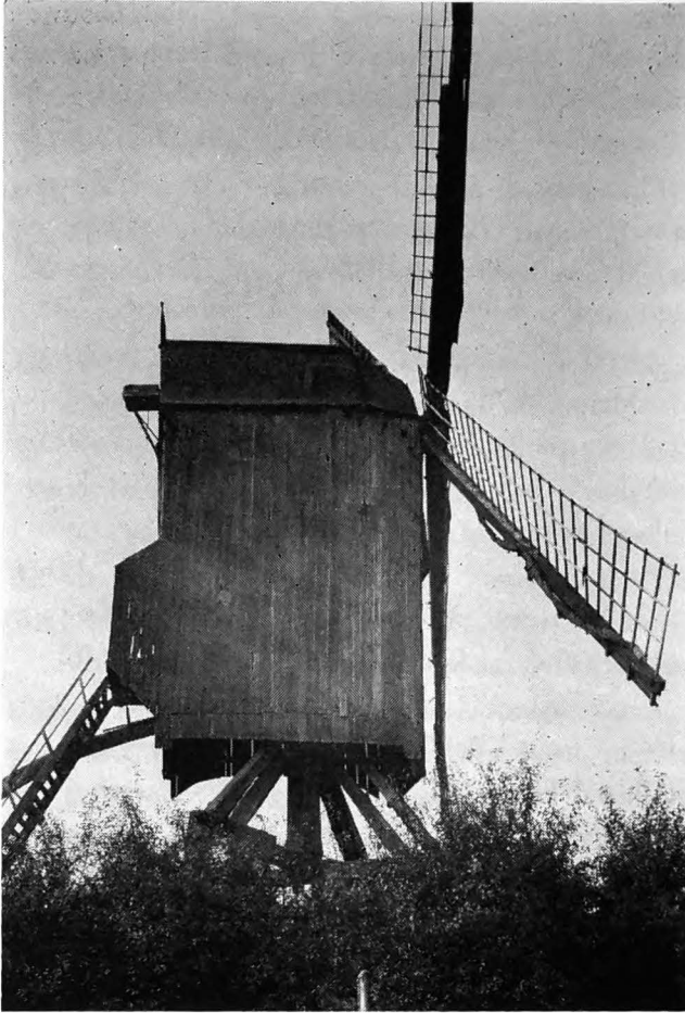
Voormalige houten windmolen te Kuitenberg, verdwenen februari 1948
